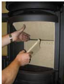
3. Kantel de tweede stenen zijplaat en verwijder hem.
