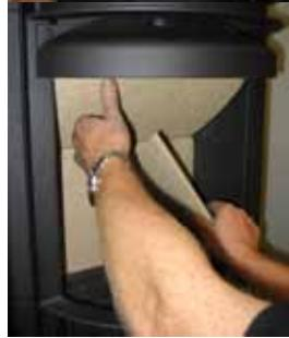
4. Nadat de stenen zijplaten en de achterstenen verwijderd zijn, schuift u het onderste rookschat naar beneden en verwijdert u het.
