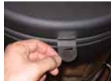
3. Nadat het papier/de aanmaakblokjes vlam hebben gevatt, zet u het deurtje op een kier van ongeveer 5 à 10 cm, zodat de schoorsteen goed kan trekken.
